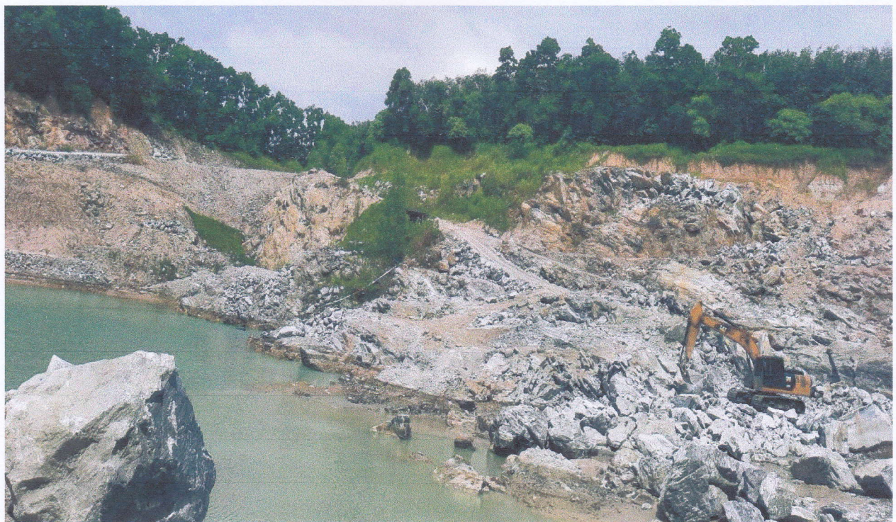
รูปที่ 7 การปรับความลาดชันของบริเวณข้ามบันไดและปรับปรุงบริเวณที่น้ำท่วมขัง
